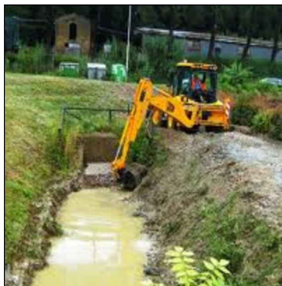
Figura 74. Pulizia dell'alveo di un corso d'acqua
